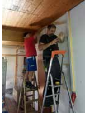
Viele fleißige Helfer bei der Renovierung im Vereinsheim. Foto: KZV
